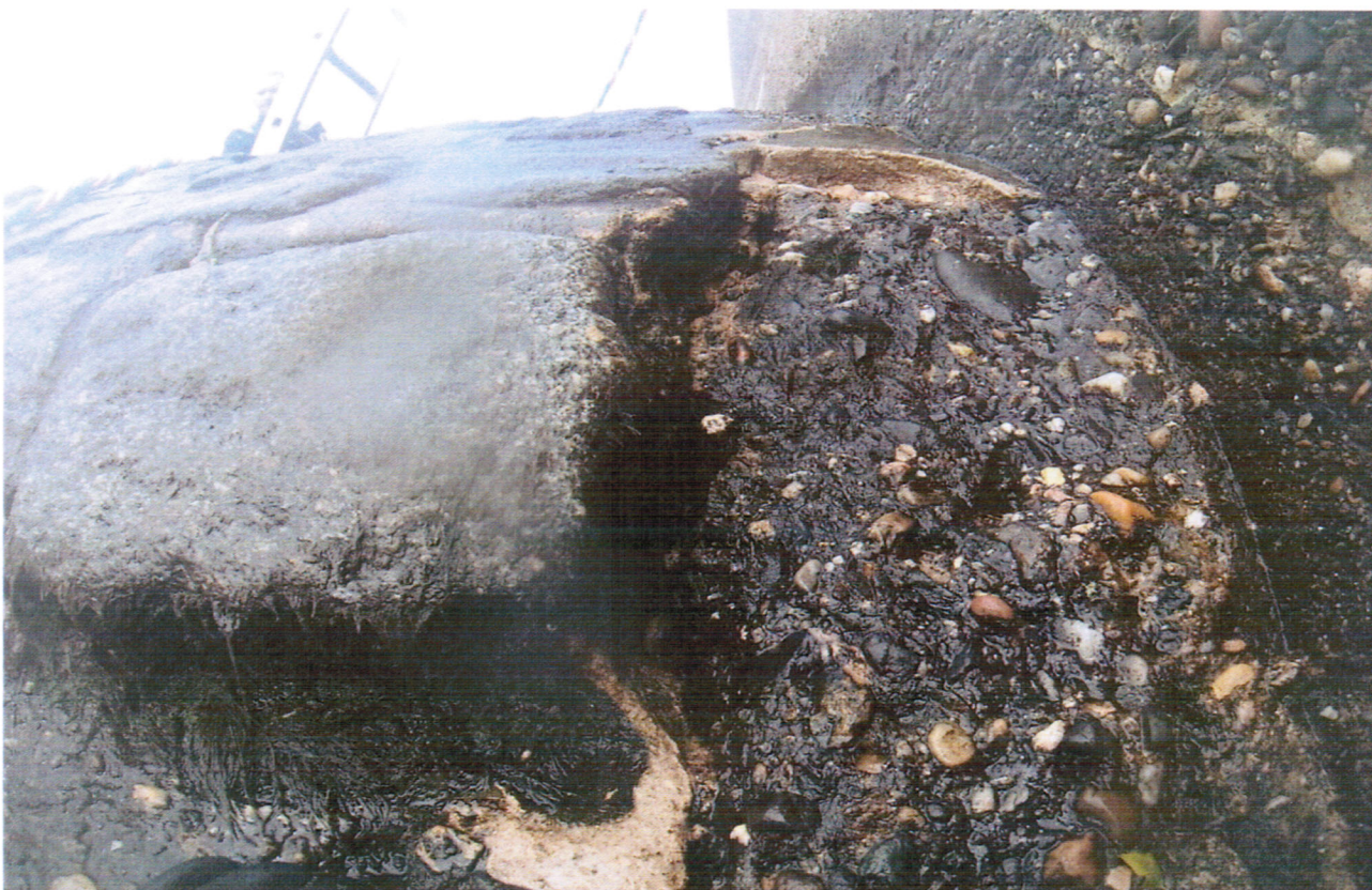
Foto: PS, a.s. Kaverna v napojení skluzu jezu a pravé dělicí zdi šterkové propusti
