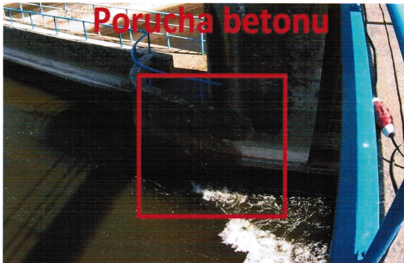
Foto: PS, a.s. Porucha betonu levého pilíře na návodní straně štěrkové propusti
