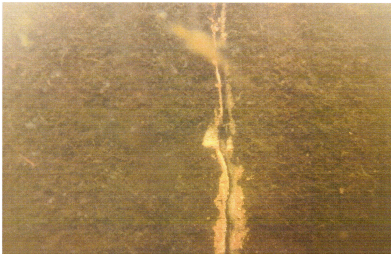
Foto: PS, a.s. Porušená pracovní spára levého pilíře štěrkové propusti
