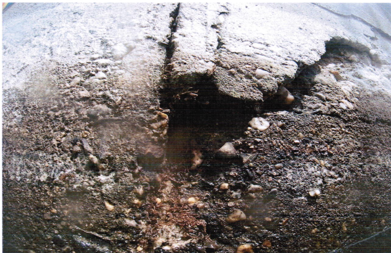
Foto: PS, a.s. Porucha betonu levého pilíře na návodní straně štěrkové propusti
