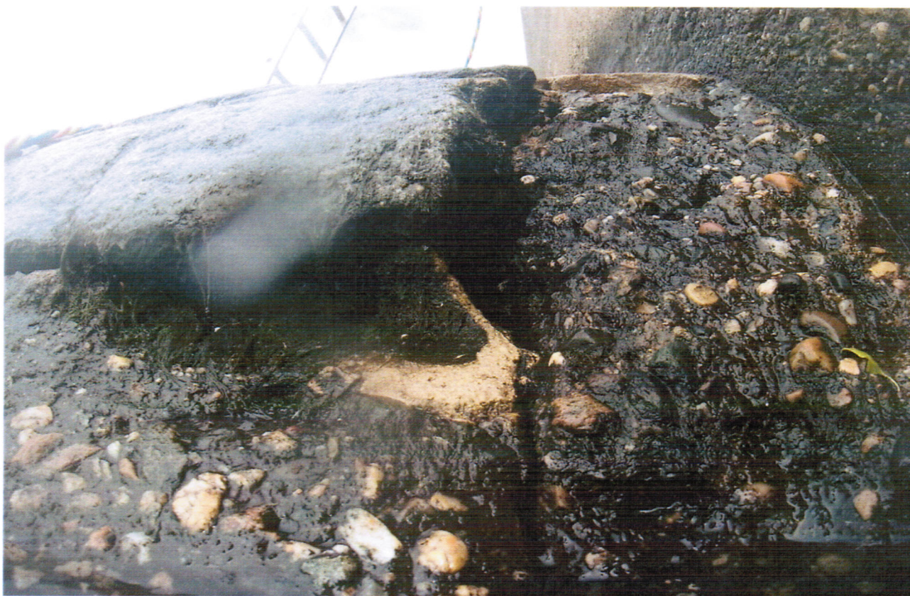
Foto: PS, a.s. Kaverna v napojení skluzu jezu a pravé dělicí zdi šterkové propusti
