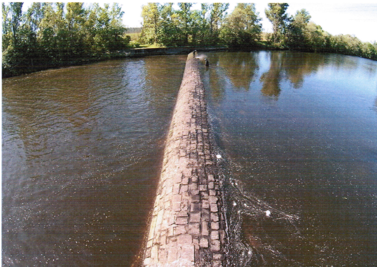
Foto: PS, a.s. Kamenné kvádry a spáry přelivné hrany pevného jezu, očištěné a bez poškození
