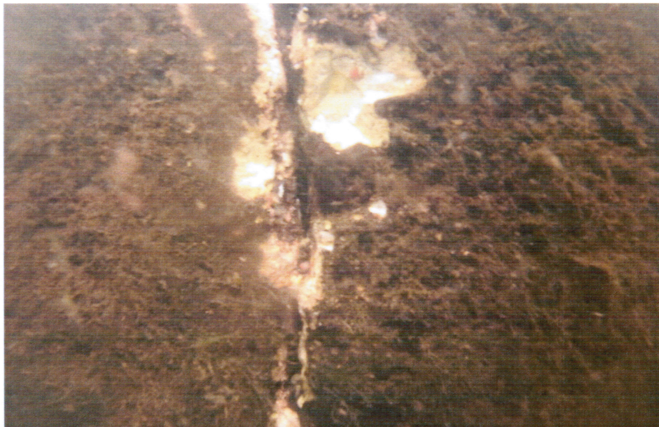
Foto: PS, a.s. Porušená pracovní spára levého pilíře štěrkové propusti
